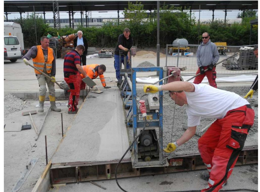
Betoneinbau mit der Rüttelbohle und glätten der Oberfläche
