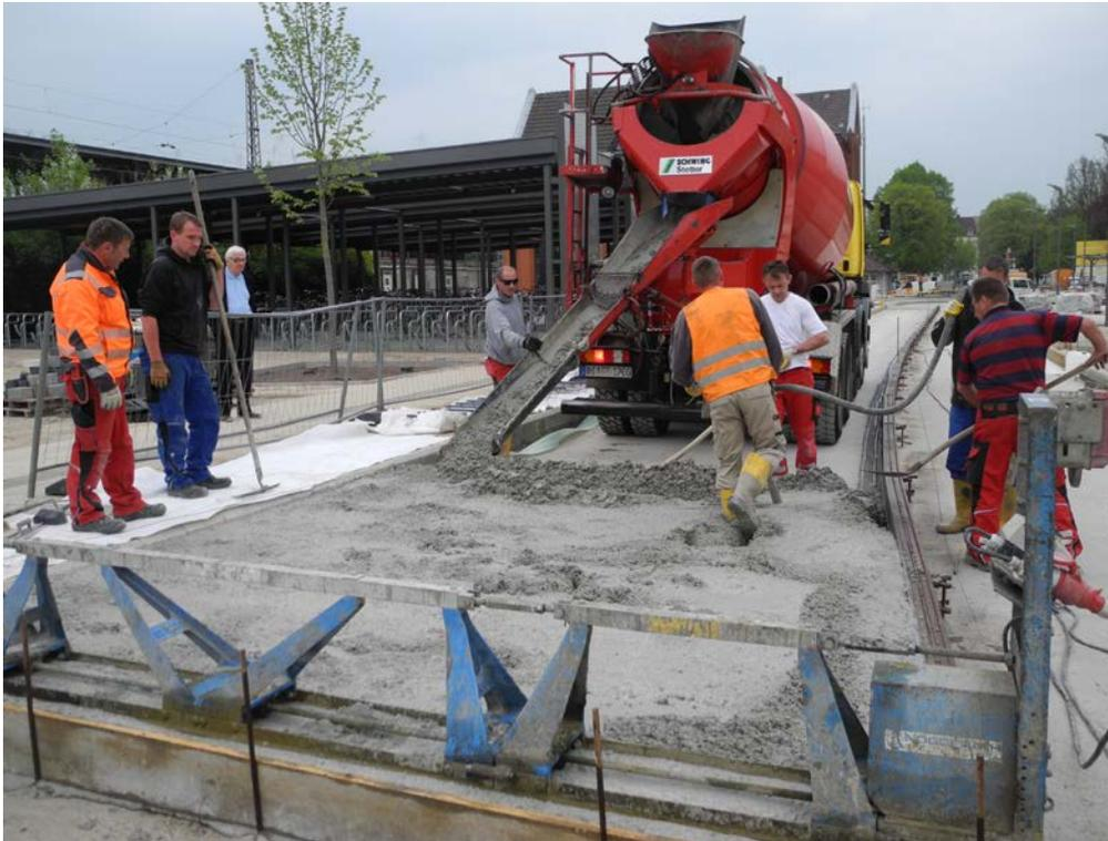
Beton-Handeinbau und Verdichtung mit Rüttelflasche
