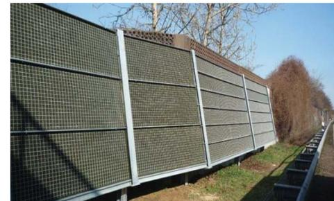
Mooswand mit Feinstaubfilterfunktion an der A61 bei Kruft
