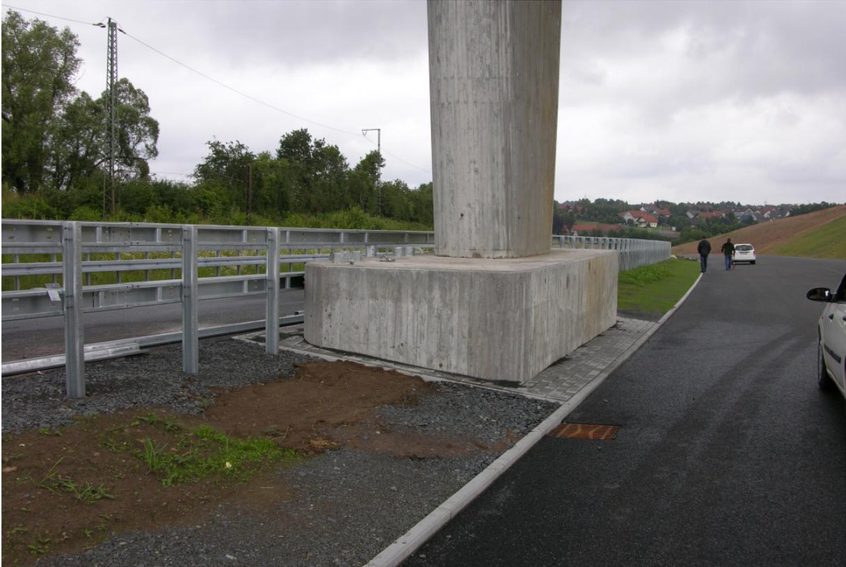
**Bild 4:** Montage der Schutzanrichtungen an einem Anprallsockel eines Brückenpfeilers bei nicht ausreichend breitem Mittelstreifen
