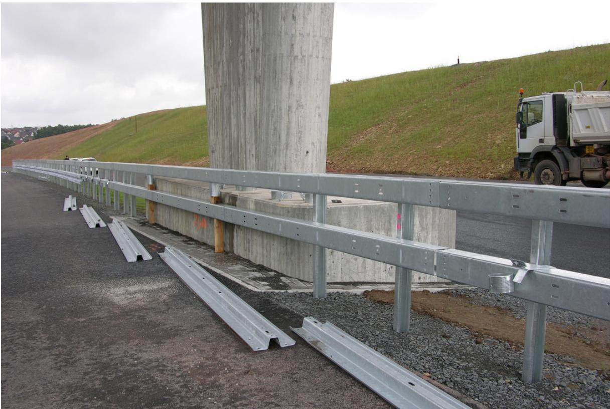
**Bild 5:** Montage der Schutzanrichtungen an einem Anprallsockel eines Brückenpfeilers bei nicht ausreichend breitem Mittelstreifen
