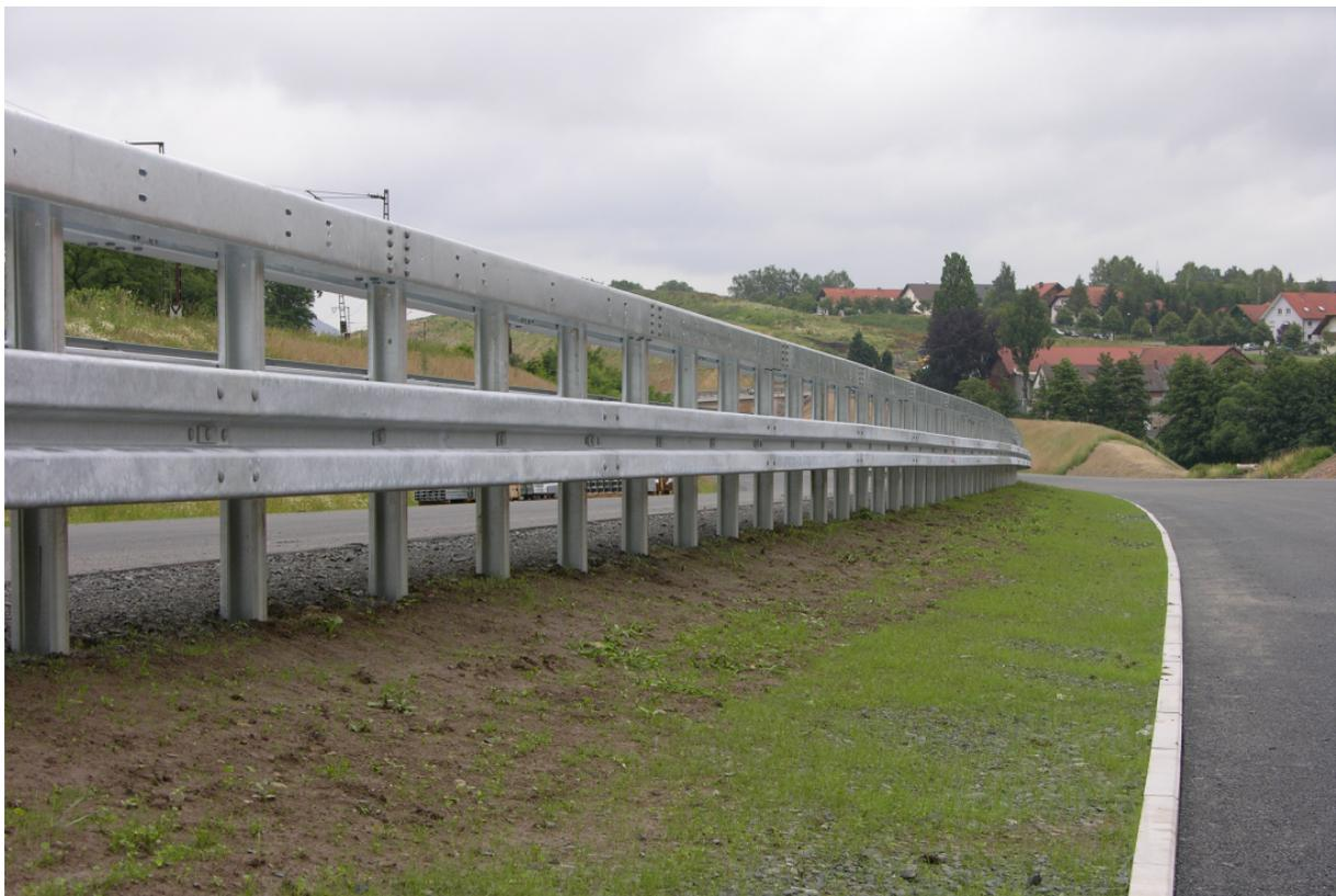
**Bild 3:** Außermittig angeordnete doppelseitige Schutzeinrichtung zur Verbesserung der Sichtweite
