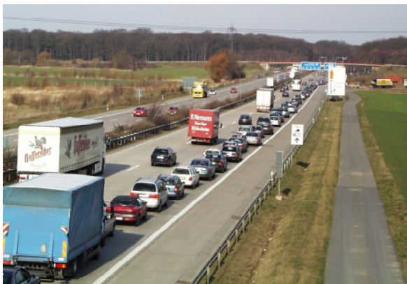
Bild 5: Rückstau auf dem rechten Fahrstreifen der Hauptfahrbahn bei einer Ausfahrt vom Typ A 2 (gemäß RAL-K-2)
