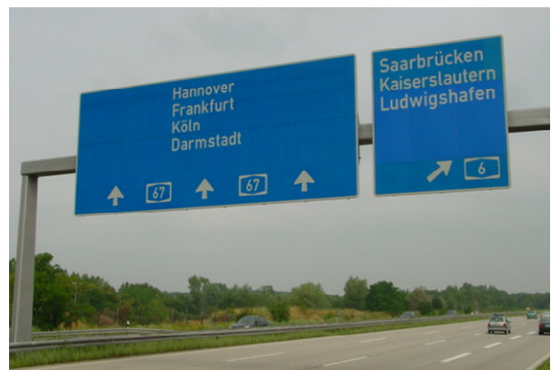
Bild 6: Richtlinienkonformer Beschilderung einer Ausfahrt vom Typ A 2 gemäß RWBA 2000
