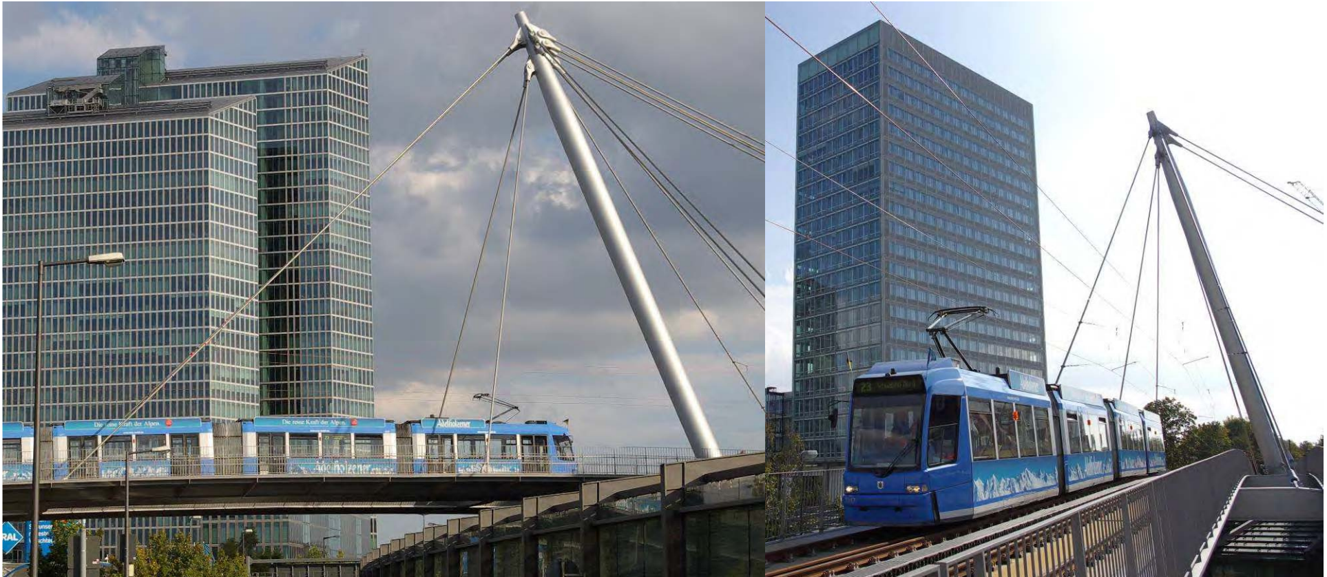
Tram 23, München: Die Straßenbahnbrücke über den Mittleren Ring prägt die Stadteinfahrt Münchens
