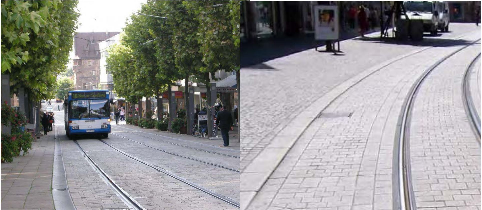
Einbindung der Straßenbahngleise in die Plattenbefestigungen eines Fußgängerbereichs, abgesetzt durch einen ertastbaren Begrenzungstreifen (links: Heilbronn, rechts: Würzburg)
