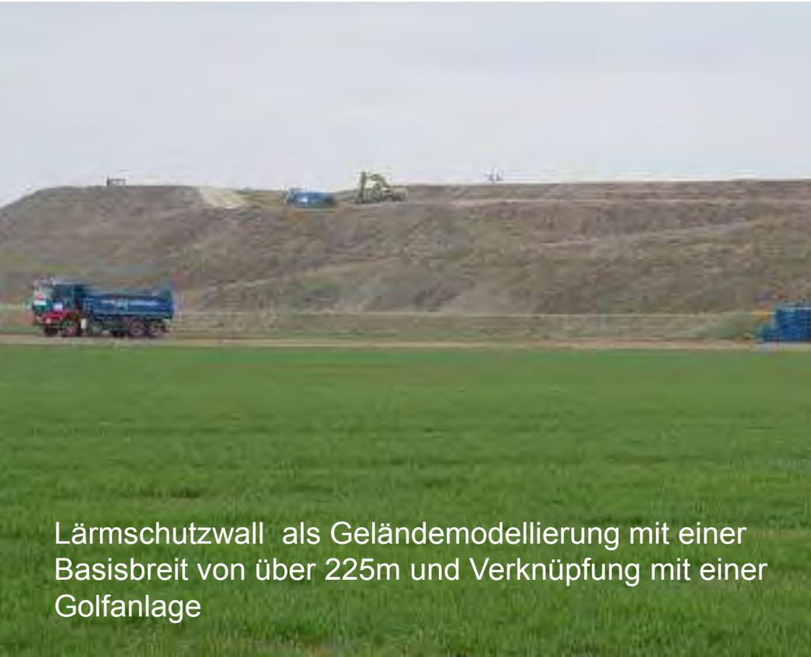
Lärmschutzwall als Geländemodellierung mit einer Basisbreite von über 225m und Verknüpfung mit einer Golfanlage
