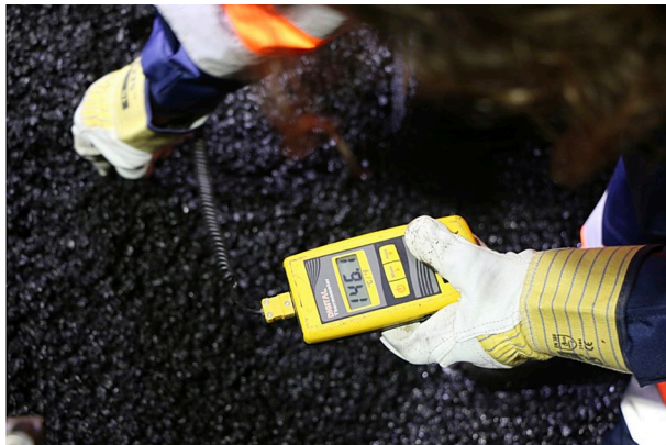
Bild 19: Temperaturmessung beim Einbau
