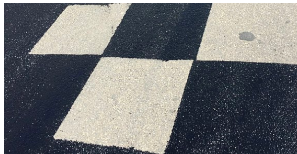
Bild 8: Prüfung der Ansprühmenge
