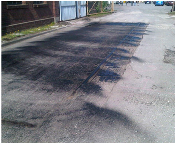
Bild 10: Unzureichend angesprühte Unterlage
