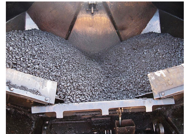
Bild 17: Entmischung Fertigerkübel
