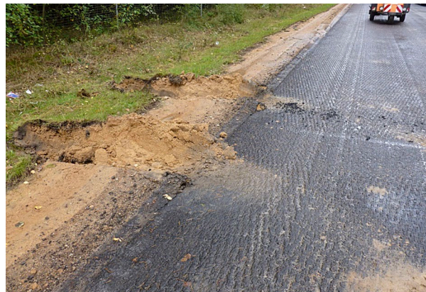
Bild 13: Verschmutzte Unterlage
