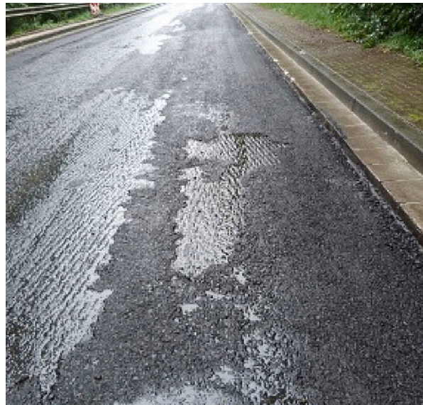
Bild 4 : Ungeeignete Unterlage (Schollenbildung)
