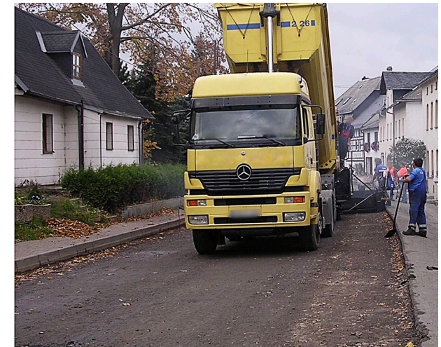
Bild 12: Verschmutzte Unterlage
