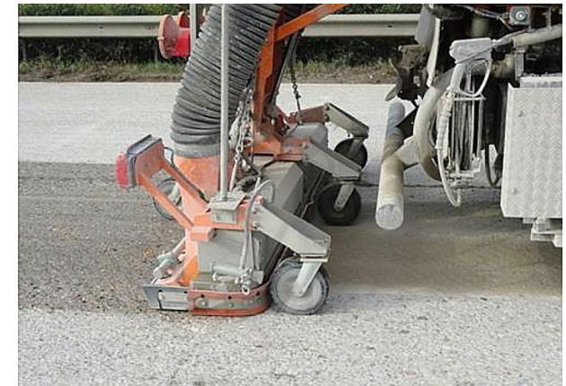
Bild 6: Reinigung einer gefrästen Unterlage mit einer Hochdruck-Drehjet-Wasch-Sauganlage
